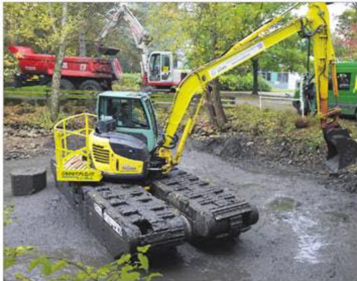
Auch ein amphibischer Greenfloat-Bagger, ein spezieller Schwimmbagger, wird bei der Sanierung des Ententeiches eingesetzt. Foto: sbr
