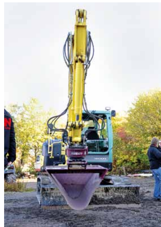
Der 10 t Yanmar Bagger war mit einem RotoTop Schnellwechsler ausgestattet, der zum einen um 360° drehbar ist und zum anderen ein schnelles Wechseln der Anbaugeräte ermöglicht.
